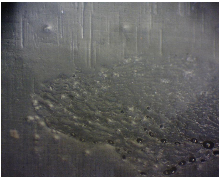
Imagem 6: Molde tirado no aerogerador nº 41 antes do tratamento.
